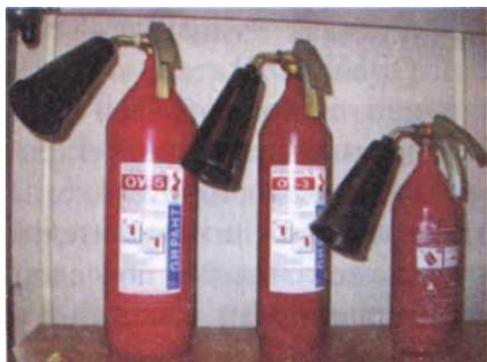
Огнетушители данного вида предназначены для тушения небольших очагов горения веществ, материалов, электроустановок (под напряжением не более 10000 В), за исключением веществ, которые горят без доступа кислорода.
